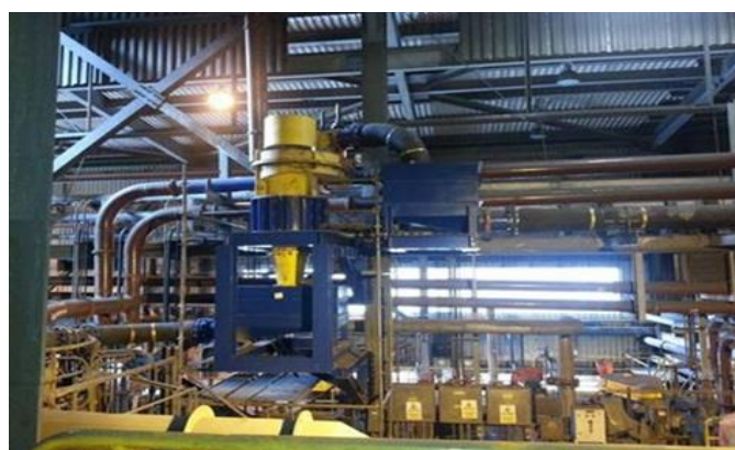
Figura. 28 Prueba piloto CVX-650. Fuente: Elaboración propia
